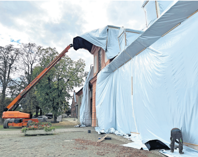
Mittels Begasung wurden jetzt Holzschädlinge im Torhaus des Hauptgestüts Graditz bekämpft. FOTO: SILKE KASTEN
