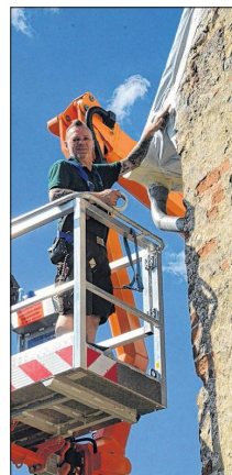
In luftiger Höhe wird jeder Schlitz mit Folie verklebt.
