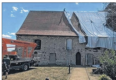
Der „winzigkleine“ Mann auf dem Dachfirst zeigt die Dimension der Folienverkleidung.
