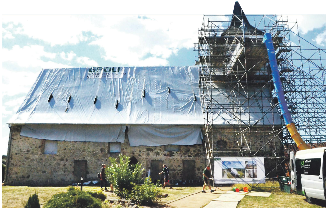
Fast wie von Christo verhüllt: Die Berger Feldsteinkirche ist derzeit gut verpackt, und zwar in gasfeste Spezialfolie. Ab heute strömt Sulfuryldifluorid in das Gebäude und macht den Schädlingen im Holz innerhalb von Stunden den Garaus. Fotos: Gesine Biermann
