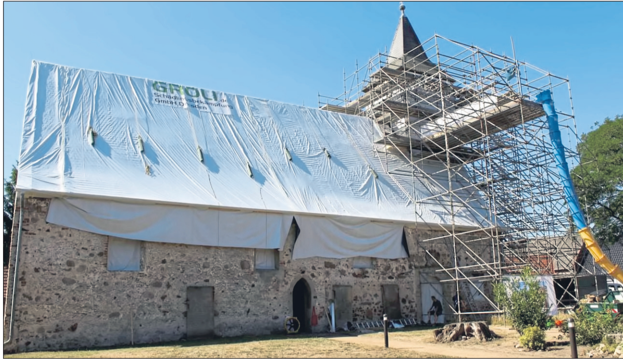
Das Dach, die Fenster und der Turm der Berger Feldsteinkirche wurden mit 1500 Quadratmetern Folie eingehüllt, damit das Gas nicht aus dem Gebäude entweichen kann.
